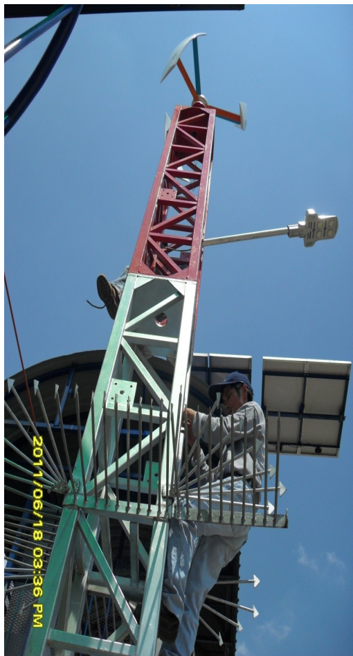
Gambar 5: Pemasangan Wind Turbine dan Lampu Limpah
