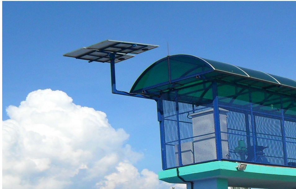
Gambar 2: Gambar Pemasangan Solar
