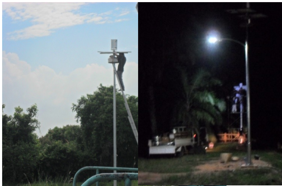
Gambar 7: Pemasangan Lampu Jalan Ladang Menggunakan Sistem hybrid
